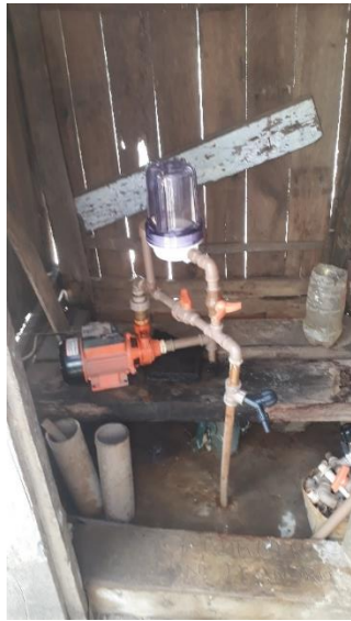
Fig. 04 – Fotos ilustrando o dosador de cloro no SAC Flor do Campo e o momento de orientações, atualizações e qualificação dos responsáveis pelo sistemas de tratamento de água da sede do município de Chaves/PA.
